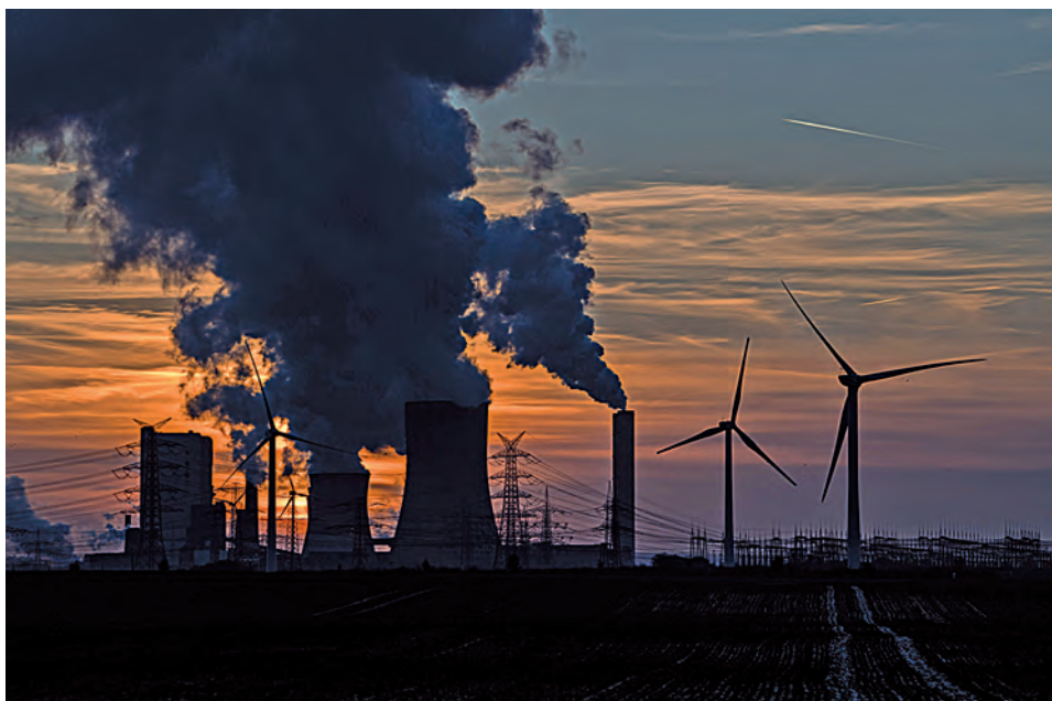
LE TORRI DI RAFFREDDAMENTO DELLA CENTRALE ELETTRICA DI NIEDERAUSSEM PRESSO COLONIA, Germania. Alimentata a carbone, è la seconda del Paese e nel 2018 ha prodotto 25,9 milioni di tonnellate di CO 2 (fot. Lukas Schulze/Getty Images)
