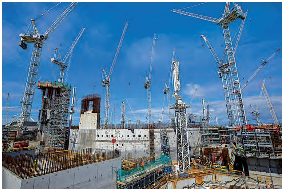
CANTIERE DELL'UNITÀ C DELLA CENTRALE NUCLEARE DI HINKLEY POINT, VICINO A BRIDGWATER, Somerset, Gran Bretagna, 28 luglio 2020. I costi di costruzione sono sostenuti per due terzi da Électricité de France (EDF) e per il restante da China general nuclear power group (CGNPG); EDF è anche proprietaria della centrale e una volta terminata l'unità C la gestirà tramite una sua affiliata, Nuclear new build generation company (NNB GenCo) (fot. Luke MacGregor/Bloomberg/Getty Images)
