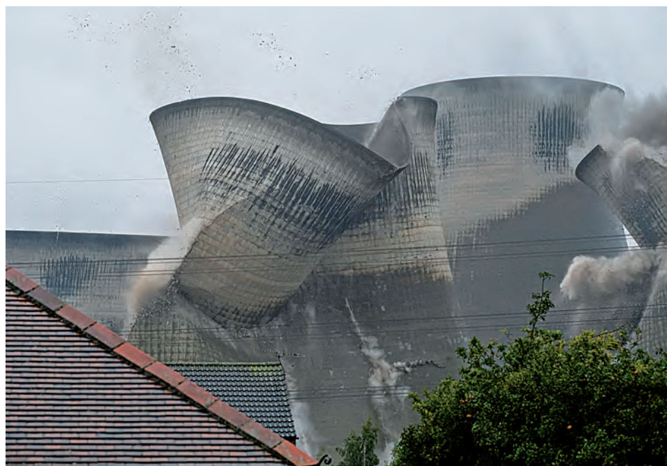
DEMOLIZIONE DI QUATTRO TORRI DI RAFFREDDAMENTO NELL'UNITÀ C (APERTA NEL 1966 E CHIUSA NEL 2016 PER IL MANCATO RISPETTO DELLA NORMATIVA SULLE EMISSIONI FISSATA DAL PARLAMENTO EUROPEO) DELLA CENTRALE ELETTRICA A CARBONE DI FERRYBRIDGE PRESSO KNOTTINGLEY, West Yorkshire, Regno Unito, 13 ottobre 2019 (fot. Ian Forsyth/Getty Images)
