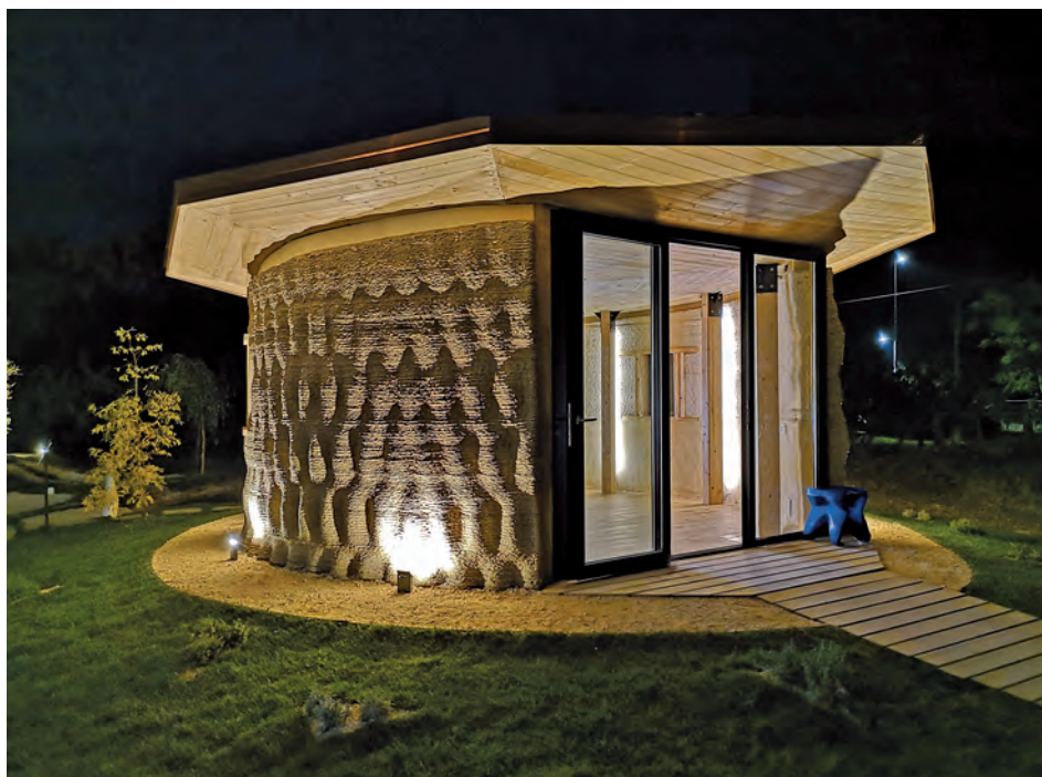
GAIA È IL PRIMO PROTOTIPO DI CASA ECOSOSTENIBILE STAMPATA IN 3D DA WASP ATTRAVERSO LA TECNOLOGIA CRANE WASP. È stata realizzata con materiali naturali: terra cruda e materiali di scarto provenienti dalla filiera del riso, Massalombarda, Ravenna, 29 settembre 2018 (per gentile concessione PhotoWASP)
